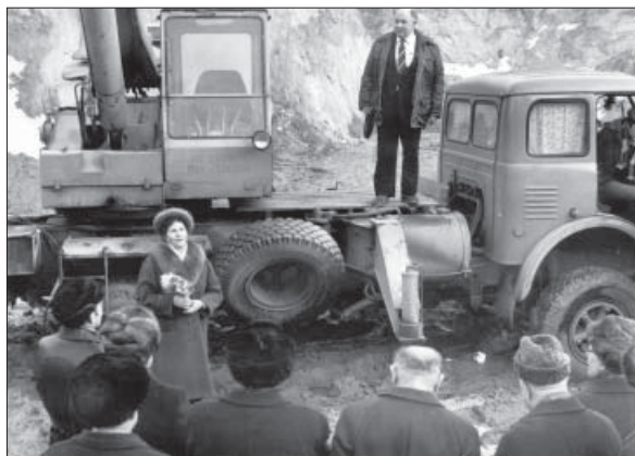
Закладання першого блоку фундаменту нового оранжерейного комплексу в НБС (1985 р.)
